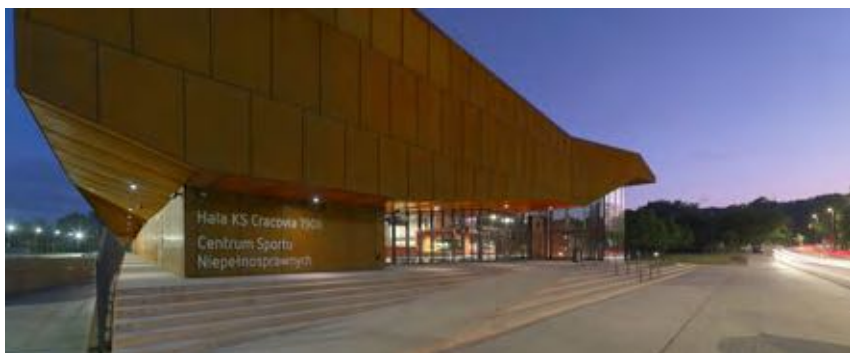
Hala KS Cracovia 1906 z Centrum Sportu Niepełnosprawnych fot. Wojciech Kryński / materiały biura Projektów Lewicki Łatak
